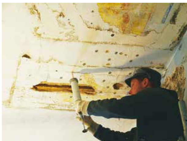
13. Atšokusio tinko injektavimas, Indrės Valkiūnienės nuotrauka, 2012
