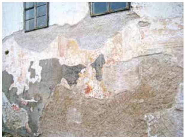
6. Rūmų rytų fasade autentiško tinko išdaužymai, ištrupėjimai užtinkuoti restauraciniu tinku, Audronės Kaušienienės nuotrauka, 2014
