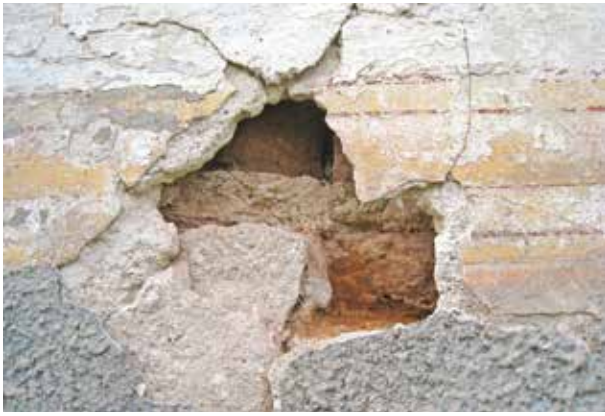
4. Rytų fasade atsidengusios autentiško tinko gilios išdažos po neaiškios kilmės cementiniu tinku, Audronės Kaušiniienės nuotrauka, 2013
