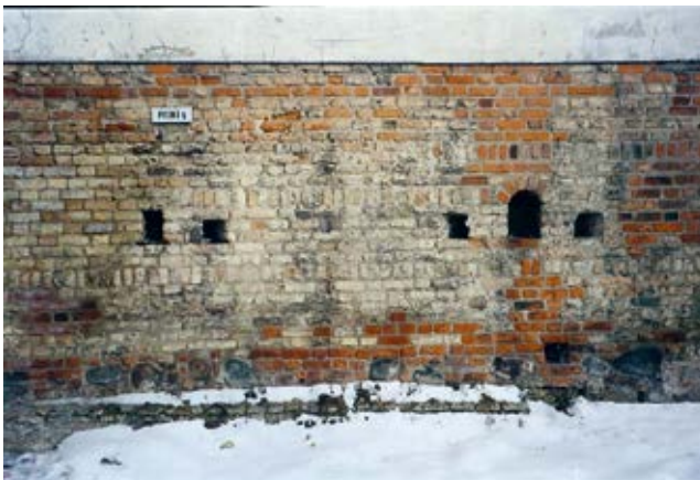
3. Vilniaus miesto sienos fragmentas su ankstyvojo statybos etapo XVI a. pradžia skirtinomis šaudymo angomis Pylimo gatvėje, prie buvusių Rūdninkų vartų. Sienos apačią dengia 2,5–3 m pakilęs gruntas, Evaldo Purlio nuotrauka, 2006
