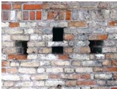
11. Šaudymo anga su vidurinėje angelėje įmūryta plyta šaunamajam ginklui atremti miesto gynybinėje sienoje prie Subačiaus vartų. Vaizdas iš išorės, Evaldo Purlio nuotrauka, 2010
